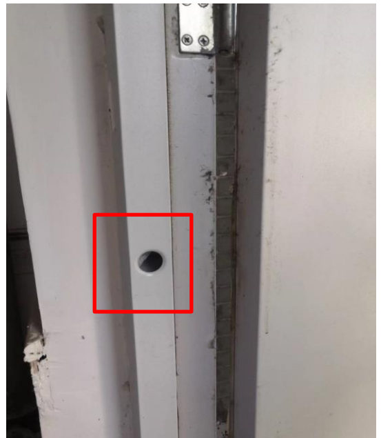
填充和封堵未使用防火材料
