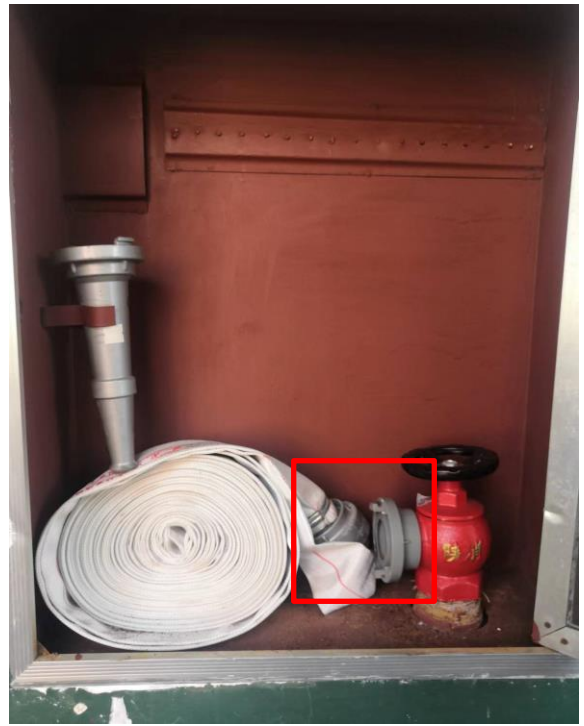
消火栓水压与自来水管连接，压力和水量不符合要求
